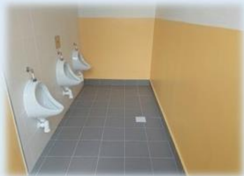
Oprava WC (budova C, 1. etapa)
