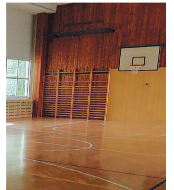
V ZŠ E. Krásnohorské mají opravenou tělocvičnu
